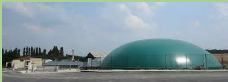
Vue du digesteur
