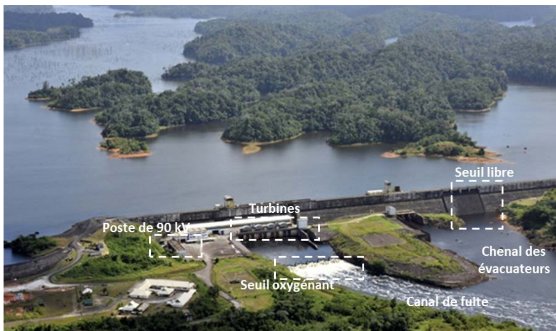
Vue d’ensemble du barrage
