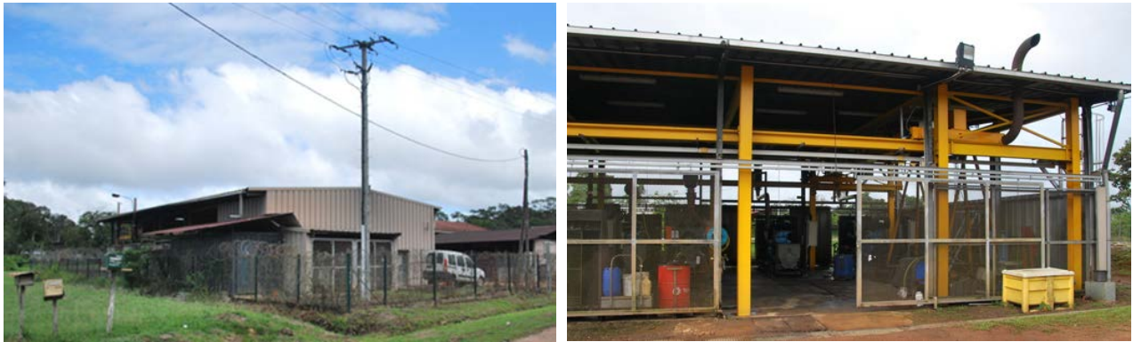
Vue de l'extérieur du bâtiment principal
