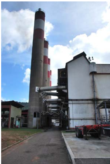
Centrale de Dégrad des Cannes
