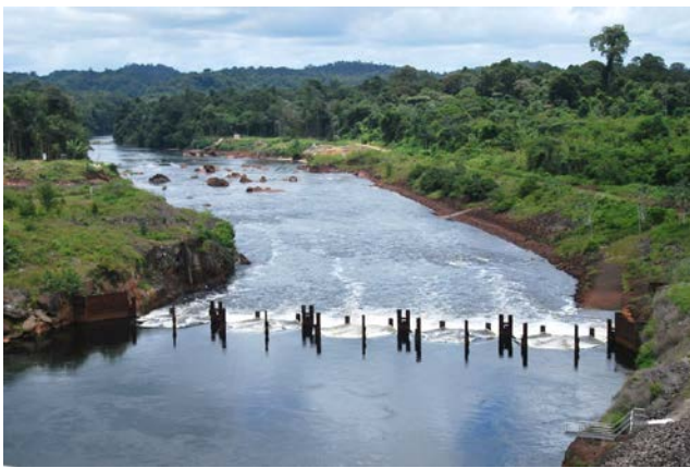
Seuil oxygénant dégazant
